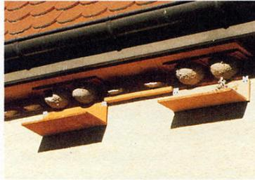
**Besonderheit Mehlschwalbe:** Die halbkugelförmigen Kunstnester für Mehlschwalben können gut unter der Traufe montiert werden, falls notwendig mit Kotbrett (Mindestabstand 40 cm). Traufüberstand mindestens 25 cm.
