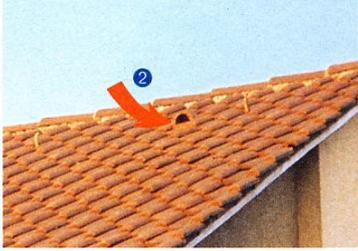
**2 Lüftungziegel:** Einflugmöglichkeit in das Dach, jedoch nur auf einer Seite des Hauses, um Durchzug zu vermeiden (Sieb heraustrennen). Es gibt auch spezielle Fledermausziegel im Handel (s. Adresse AG Ziegeldach). Unterspannbahn an diesen Stellen etwas öffnen für den Durchschlupf in den Dachraum, ggf. Überlappungen zum Durchkriechen ausbilden (für Fledermaus). Im Firstbereich und in nicht ausgebauten Dachbereichen keine Unterspannbahnen verwenden.
